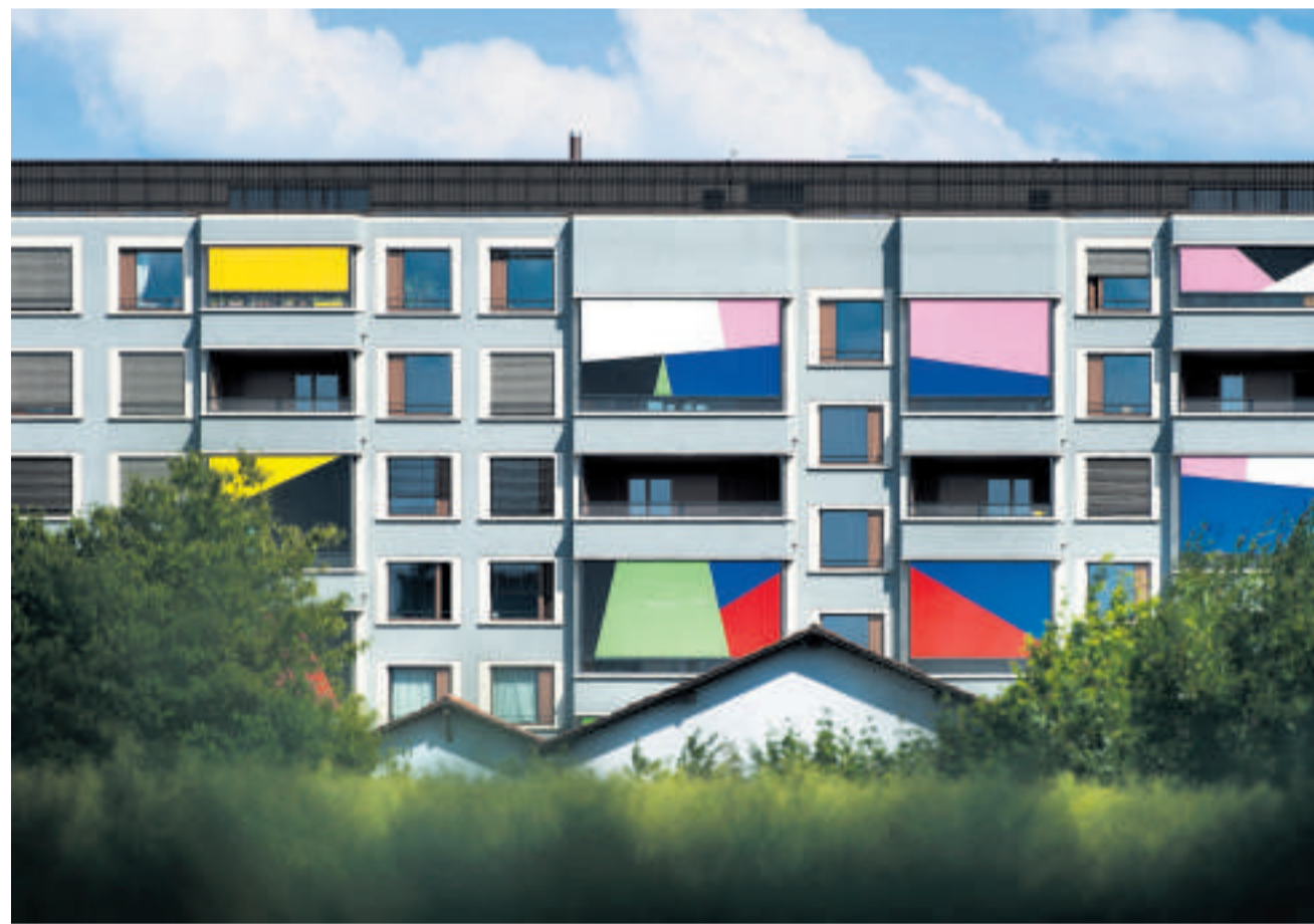
Die Westfassade des neuen Studentenhauses Aspholz in Zürich Affoltern wird von Kunst am Bau geschmückt.
